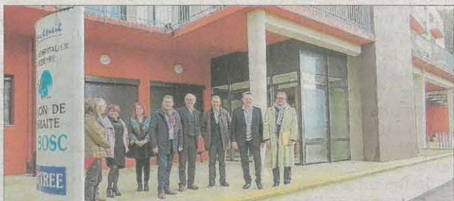
Lors de la visite du chantier terminé.
